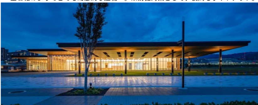
大屋根と落ち着いた色調のファサード(夜景)
