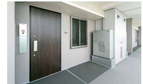
各住戸共用部に家庭用燃料電池コージェネレーションシステム設置
