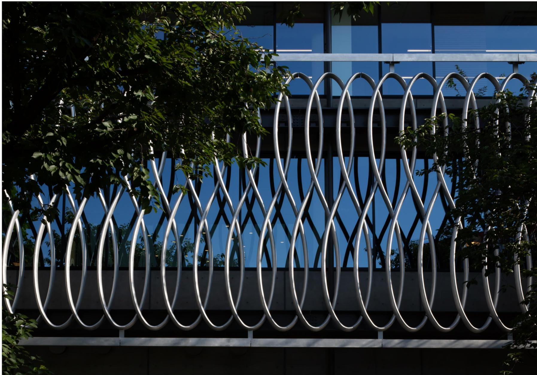
「環縫いリレーバー」ディテール、日本国内で製造出来る最大サイズとなる高さ5.4mのアルミダイキャストリレーバー
