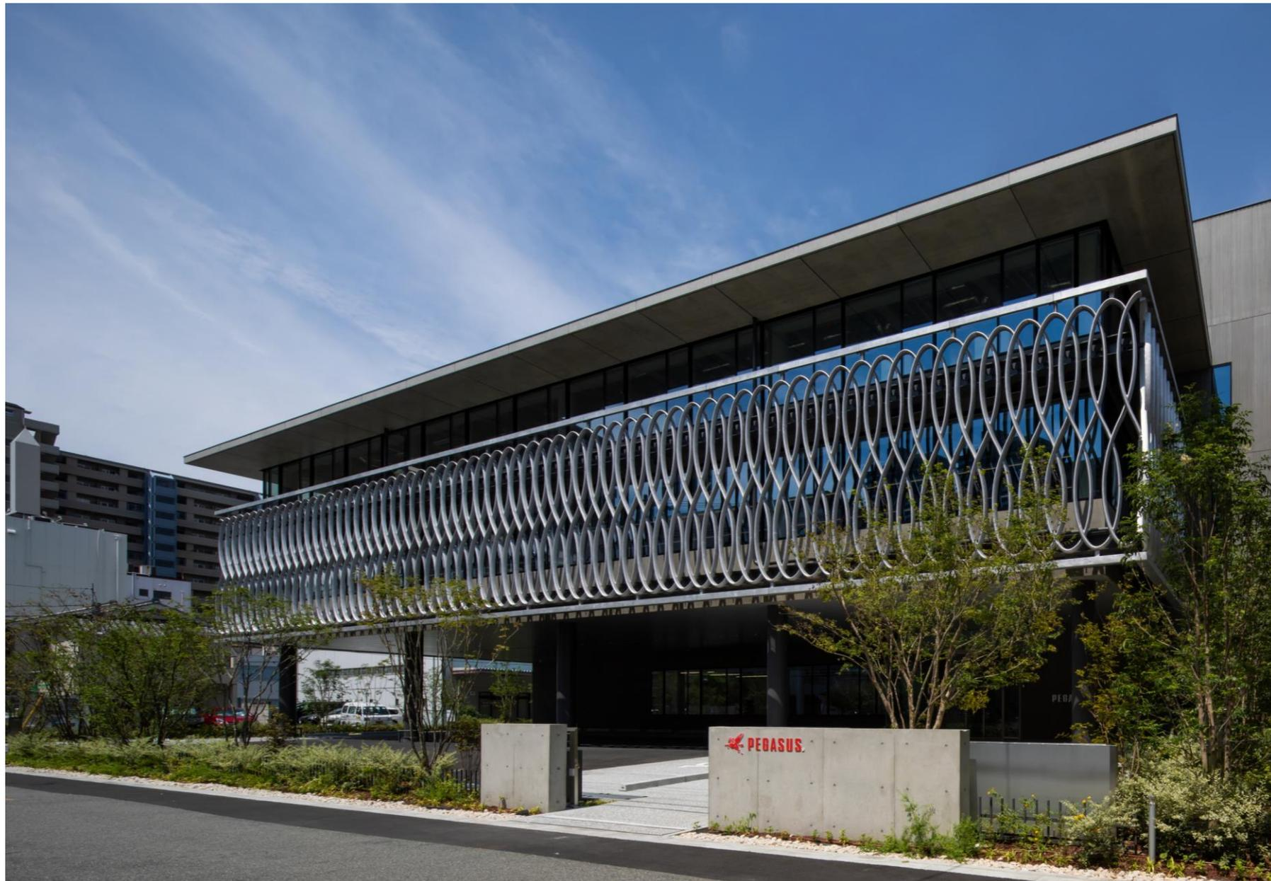
日射遮蔽、視線制御、自然採光・通風に配慮した企業のアイデンティティーを表す「環縫いレーバー」
