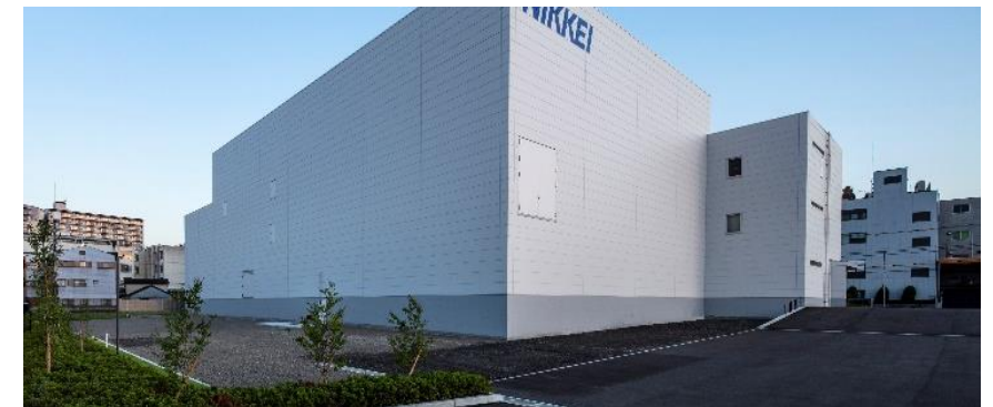
建物外構に砕石敷の雨水貯留池を設置
