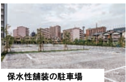
保水性舗装の駐車場
