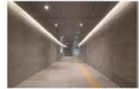
地下接続通路
