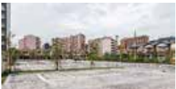
保水性舗装の駐車場
