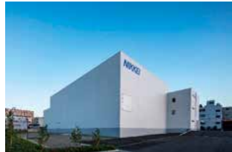
建物外構に砕石敷の雨水貯留池を設置
