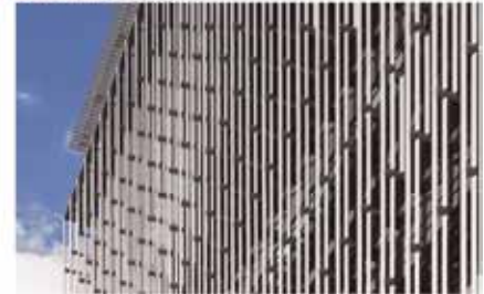
御堂筋のアルミ縦ルーバー
