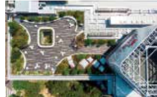
雨水を緑化散水に利用
