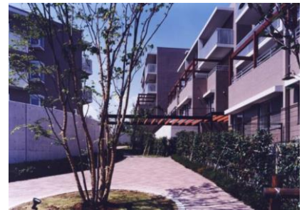
アプローチ広場から住棟を見る(撮影: 齋部功)
