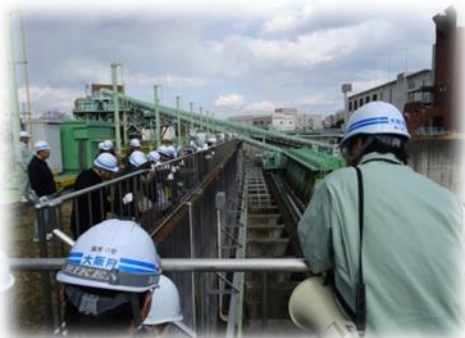
雨水沈砂池を上から見下ろす
