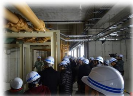
普段は入れない管廊。探検気分
