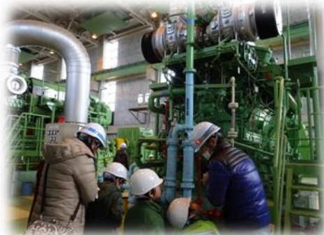
大迫力! 雨水ポンプの試運転
