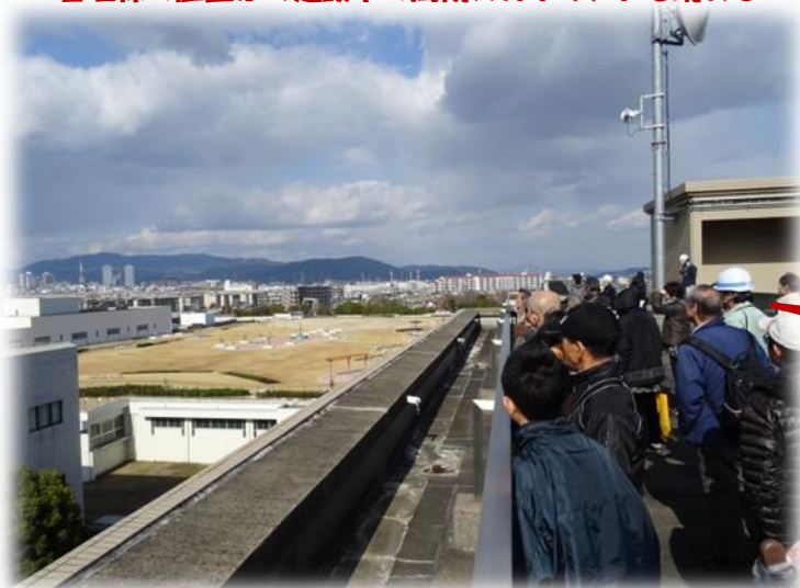
管理棟の屋上から建設中の高槻スカイランドを眺める
