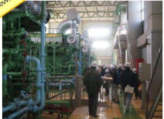
雨水を排除する雨水ポンプたち。大きさと数の多さに圧倒されていました！13台全て動かすと25mプール（540トン）が約8秒で満杯になります！！
