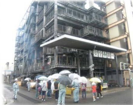
溶融炉では汚泥を溶かして スラグにしています
