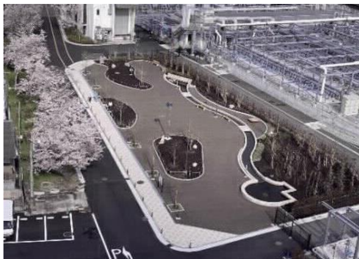
中浜東下水処理場の再構築事例
