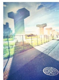
東大阪市本庄西一丁目 「大阪モノレール橋脚」
