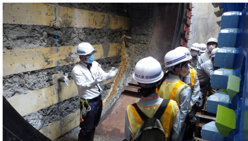
シールド工事の現場講習会 「若手職員を中心とした現場講習会を開催等により、人材育成に努めています。」
