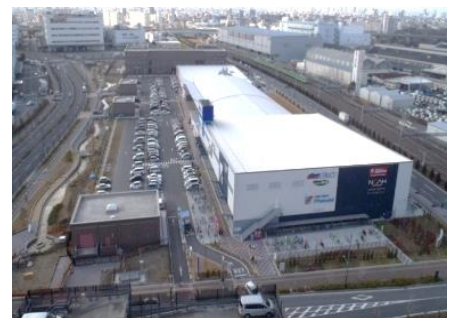
写真 21 用地の貸付事例(菟華水みらいセンター) (水処理施設の大部分を地下式とし、その上部空間を民間事業者に貸付けしています。)
