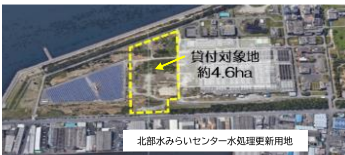
写真 20 更新用地の貸付事例(北部水みらいセンター) (将来の水処理更新用地(約4.6ha)を民間事業者に貸付けしています。)
