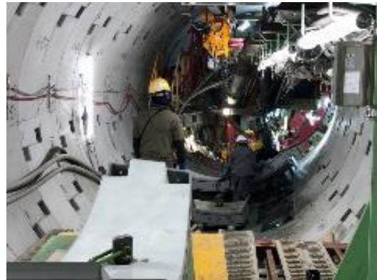
写真 14 内部施工状況 (門真守口増補幹線)
