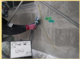
建築 (外壁補修)
