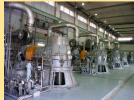
機械設備更新 (雨水ポンプ)
