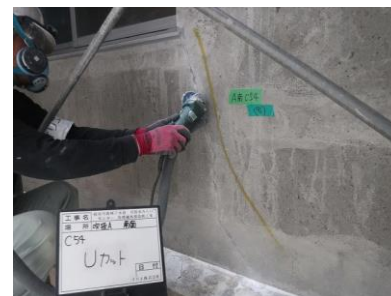
建築外壁補修工事
