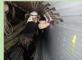
管渠の耐震化 (管更生)
