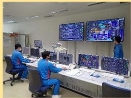
電気設備更新 (監視制御)
