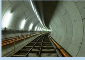
下水道増補幹線の整備 (シールド工)
