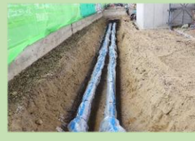
送泥管の耐震化 (布設替)
