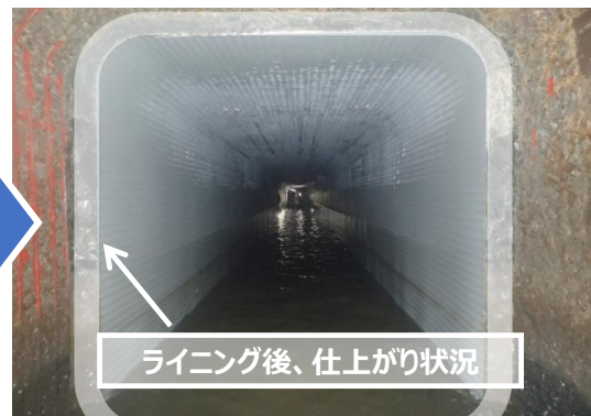
下水管渠内の完了状況
