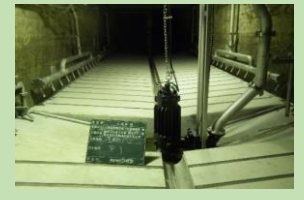
合流改善対策 (沈砂池ドライ化)
