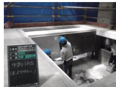
処理場の防食工事
