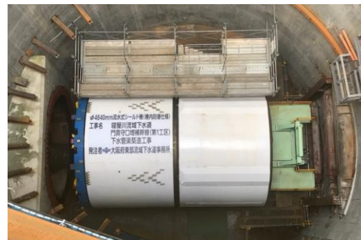
増補幹線シールドマシン（門真守口増補幹線）
