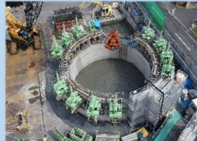
下水道増補幹線の整備 (立坑工)
