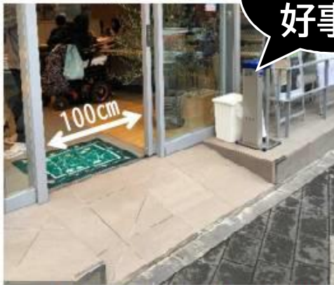
●改修による自動式引き戸の設置、出入口前後の高低差の解消
