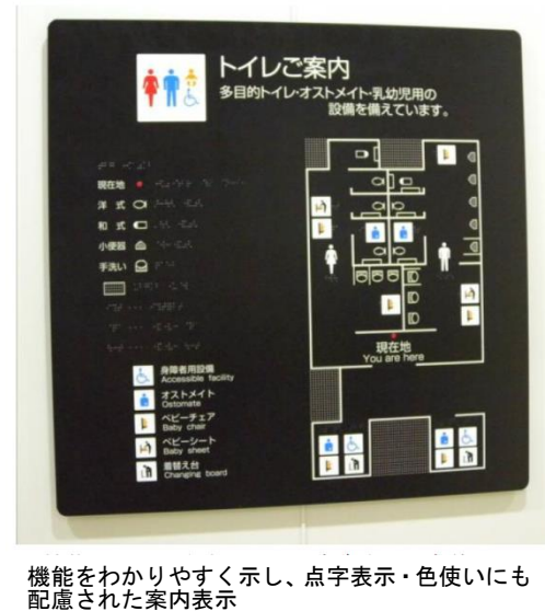
☆便所の触知図案内板の設置例
