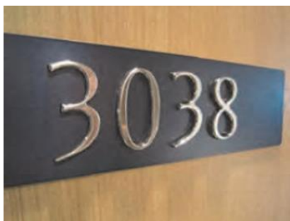
室番号の浮き彫り表示の例
