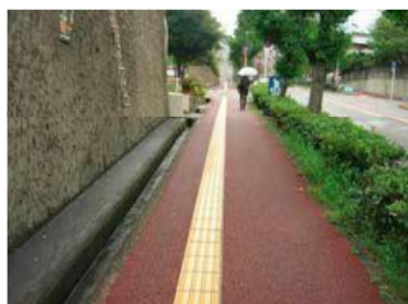
誘導ブロックの敷設
