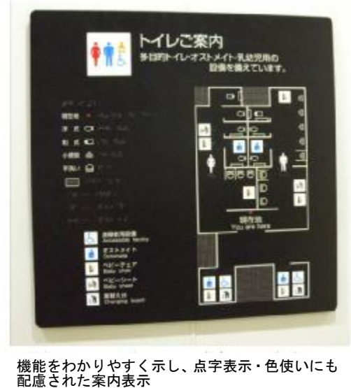
☆ 便所の触知図案内板の設置例
