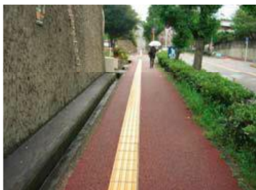
誘導ブロックの敷設
