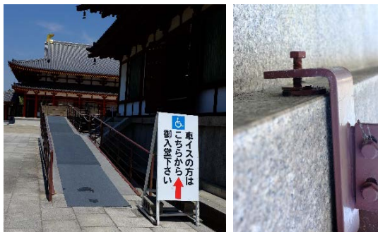
図2 基壇への仮設スロープの設置
