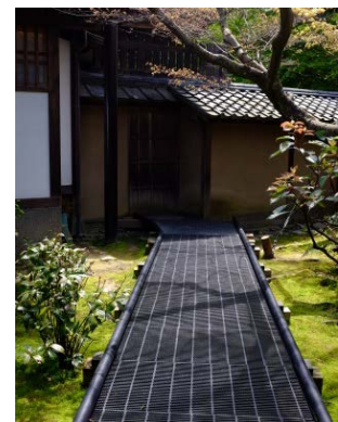
図6 坪庭に設置された車いす用ルート
