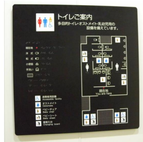
☆ 便所の触知図案内板の設置例
