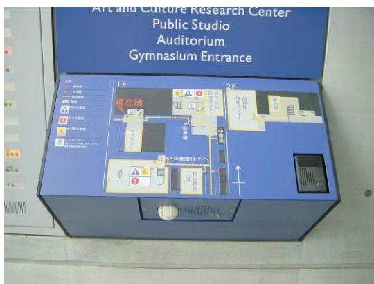
☆図 13.2 触知図案内板の例
