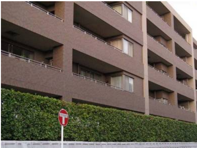
外壁と一体的なバルコニーですっきりとしたデザインになっています。
