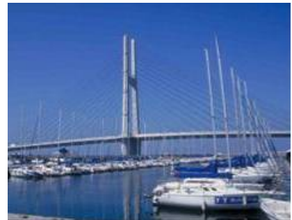
田尻スカイブリッジ
