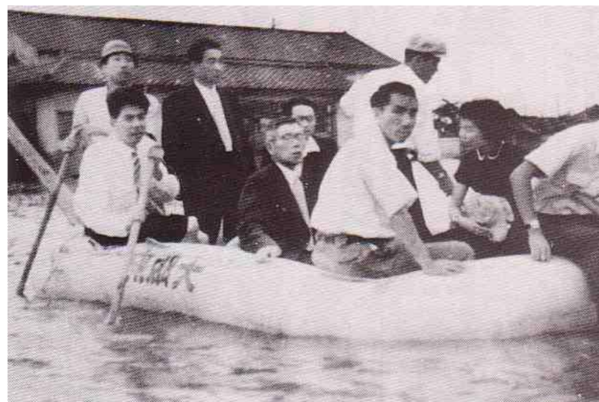
昭和32年6月の浸水被害の状況
