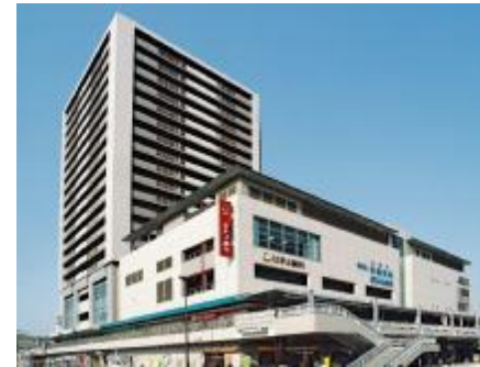
北野田駅前A地区 (H17.2 建築工事完了)
