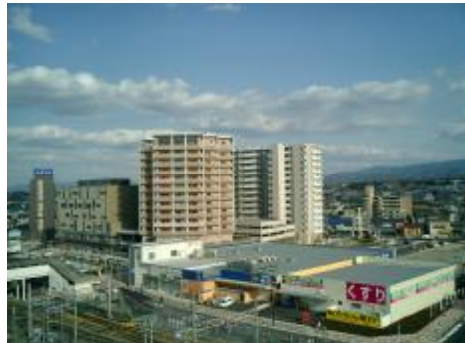
東岸和田駅東地区 (H23.2 建築工事了)
