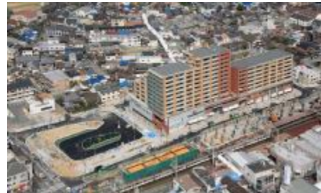
河内花園駅前地区 (H20.2 建築工事完了)
