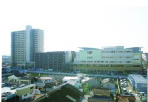
和泉府中駅東第一地区 (H23.2 建築工事了)
