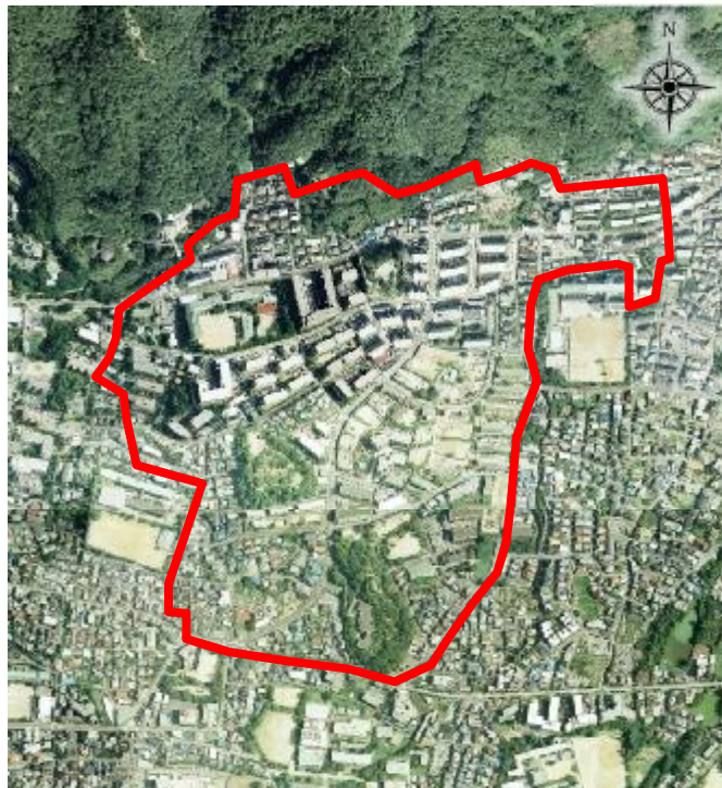
▼航空写真 (施行後：平成11年)
