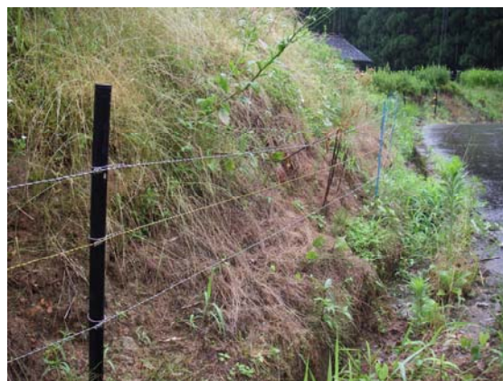
植物が柵線に触れ、漏電している電気柵
