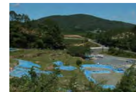
新名神高速道路建設で変貌しつつある竜王山山麓、千提寺
