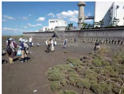
右岸(東岸)の河口付近
