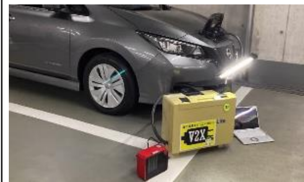
可搬式給電装置を用いて電気自動車から給電
