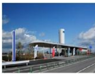
イワタニ水素ステーション 関西国際空港
