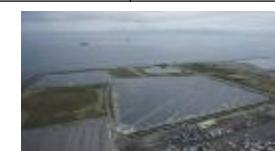
泉大津大規模太陽光発電施設
