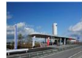
イワタニ水素ステーション 関西国際空港
