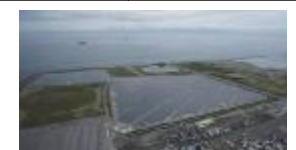
泉大津大規模太陽光発電施設
