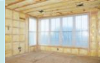
天井・壁・床等の断熱改修
