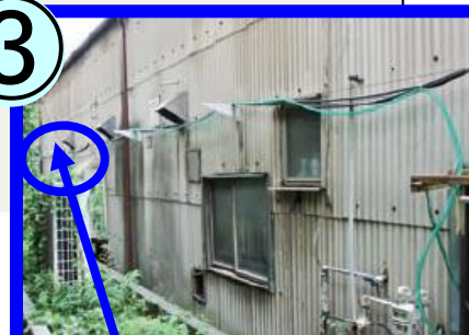
ホースに穴をあけ、水を 室外機の天板にかける
