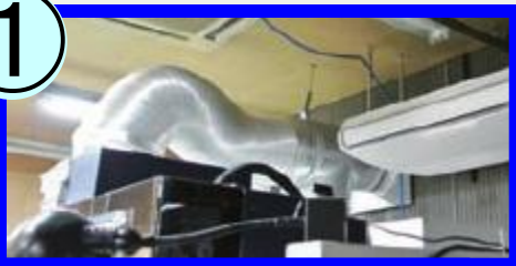
室内にあるコンプレッサ の上にダクトを設置
