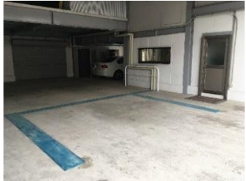
駐車場にボアホールを施工
