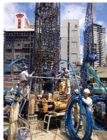
地中熱交換杭施工状況
