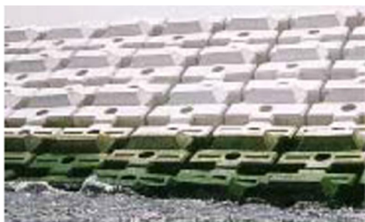
図4 大阪沖埋立処分場の緩傾斜護岸
