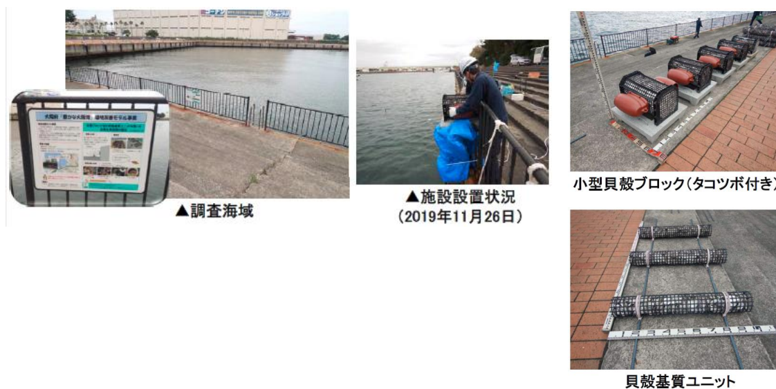
図 II - 1 - 23 泉大津旧港階段岸壁での設置状況(左)及び設置した基質(右)
