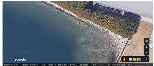
図Ⅱ-3-7 砂の堆積が見られる護岸の例
