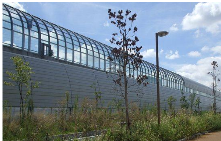
遮音壁の設置
