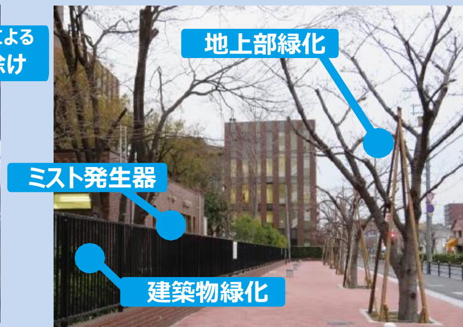
大阪経済大学 (大阪市東淀川区) 2018年度整備
