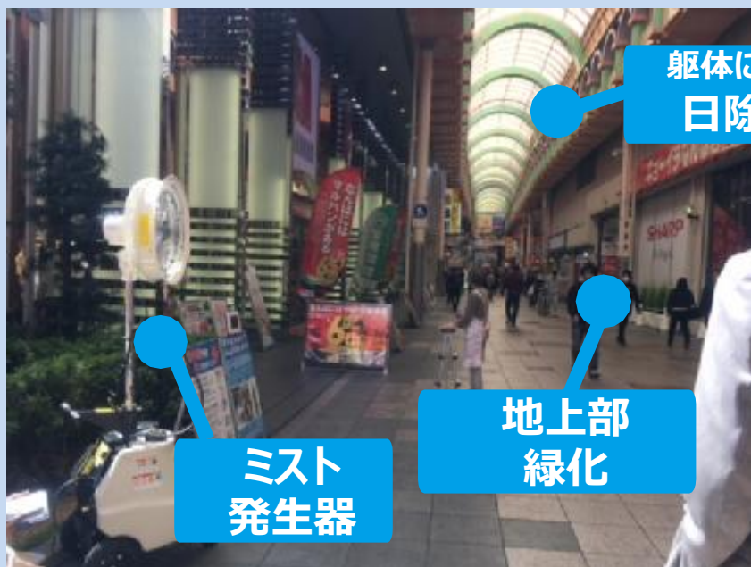
難波センター街商店街 (大阪市中央区) 2017年度整備
