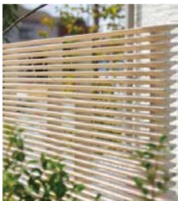
写真 4-24 冷却ルーバー 14
