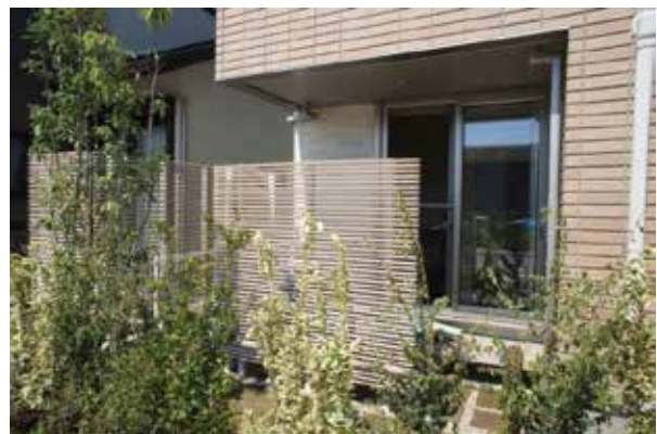
写真 4-25 冷却ルーバー 15
