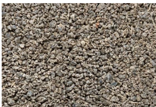
写真 保水性ブロックの舗装面
