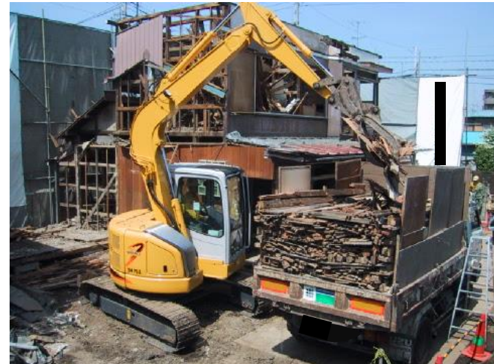
建設発生木材の搬出
