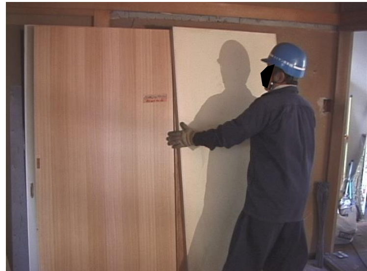
建具の取り外し
