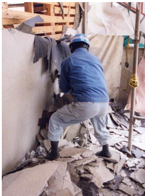
外装材の取り壊し
