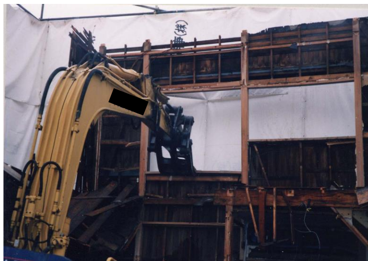
上部構造部分の取り壊し
