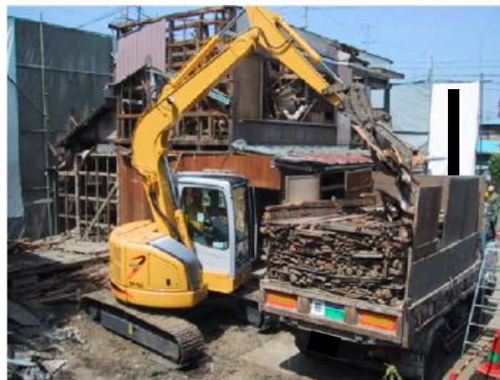
建設発生木材の搬出
