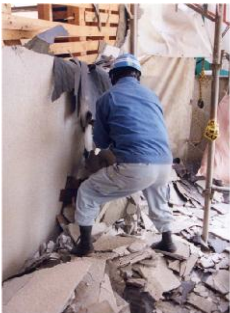
外装材の取り壊し
