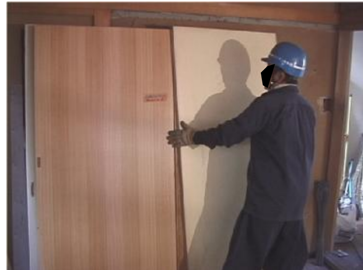
建具の取り外し
