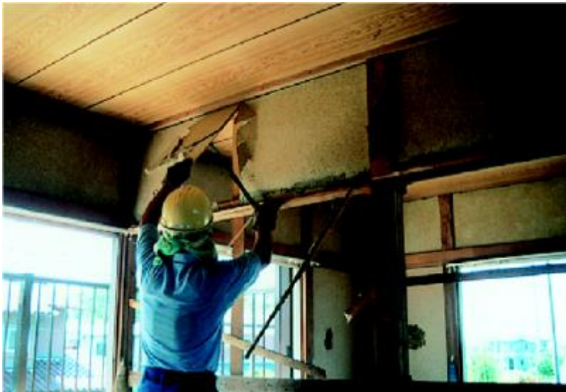
内装材の取り外し
