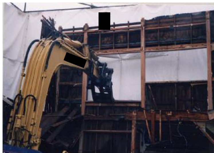
上部構造部分の取り壊し
