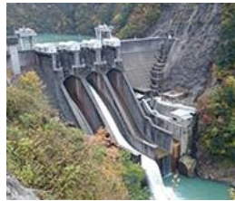
出し平発電所（水力）
