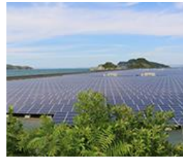
有田太陽光発電所
