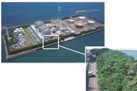
御坊発電所のエコロジー緑化と拡大写真
