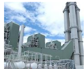
姫路第二発電所（火力）
