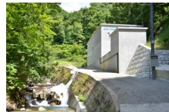
水力発電所（岐阜県）
