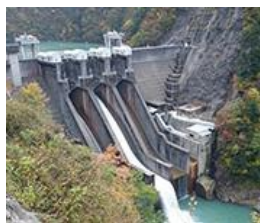
だ だいら 出し平発電所（水力）
