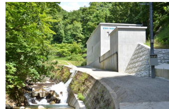
水力発電所（岐阜県）
