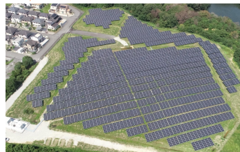
太陽光発電所（奈良県）
