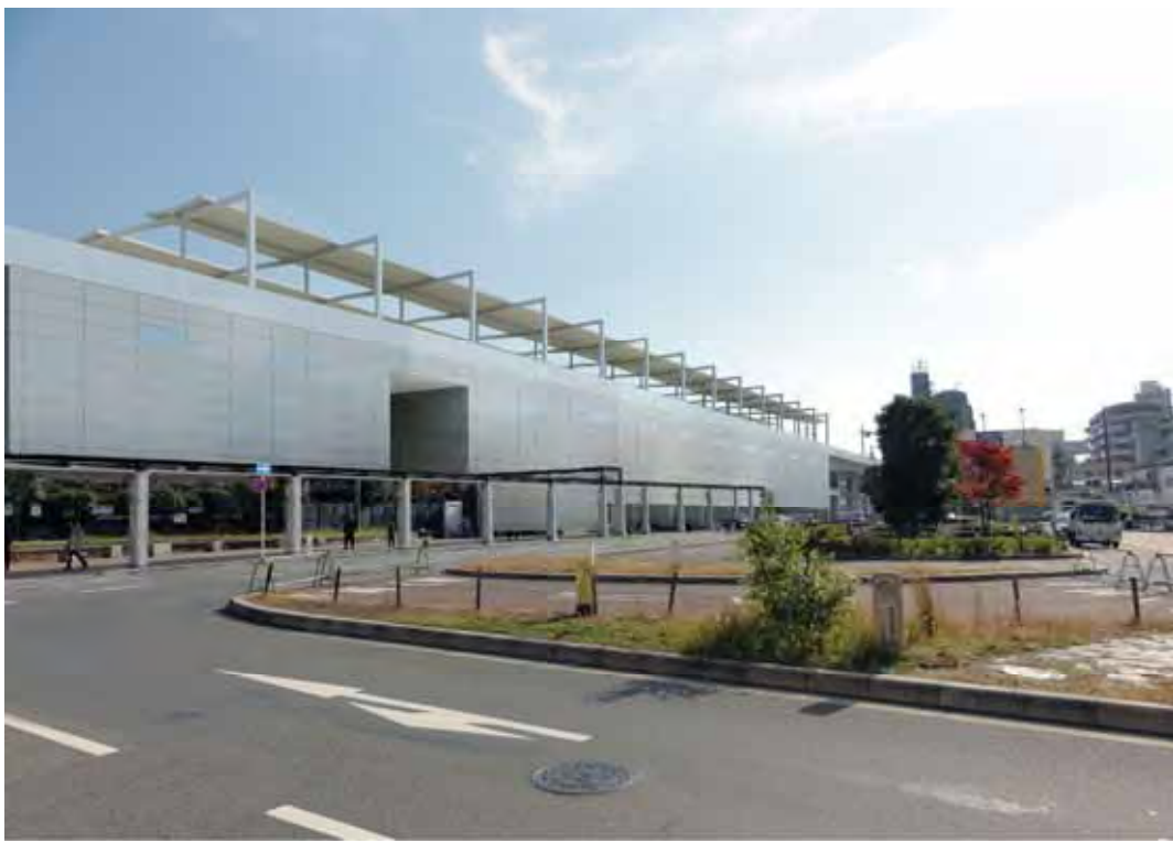
写真 6.9.17 No.8 : 香里園駅付近（駅ロータリーから駅舎方向の眺望）
