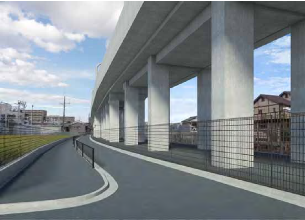
写真 6.9.16 No.7 : 南中振公園付近（公園入口から北方向の眺望）
