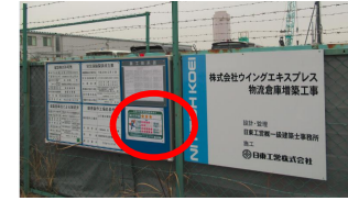
通行人や工事関係者に見やすい箇所に掲載
