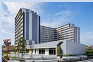
東大阪市営上小阪東住宅
