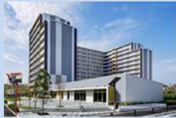
東大阪市営上小阪東住宅
