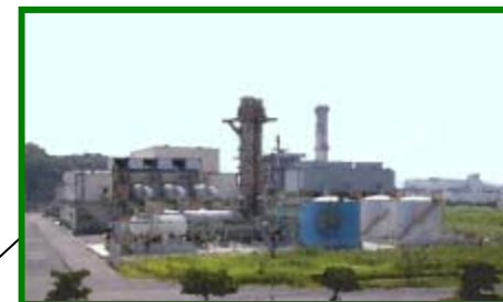
エネット茨城発電所 1.5万kW
