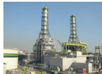
東京ガス川崎天然ガス発電所 80万kW
