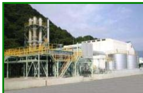
エネット舞鶴発電所 3.5万kW
