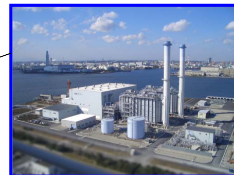
東京ガス扇島パワー発電所 81万kW
