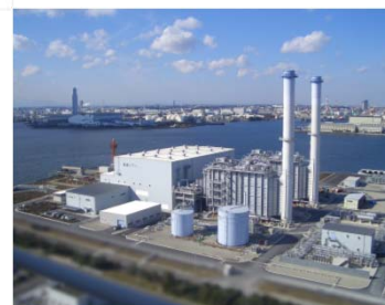
東京ガス扇島パワー発電所 81万kW
